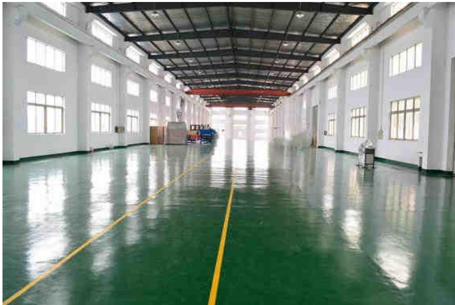
图 2-3 本项目厂房现状图
