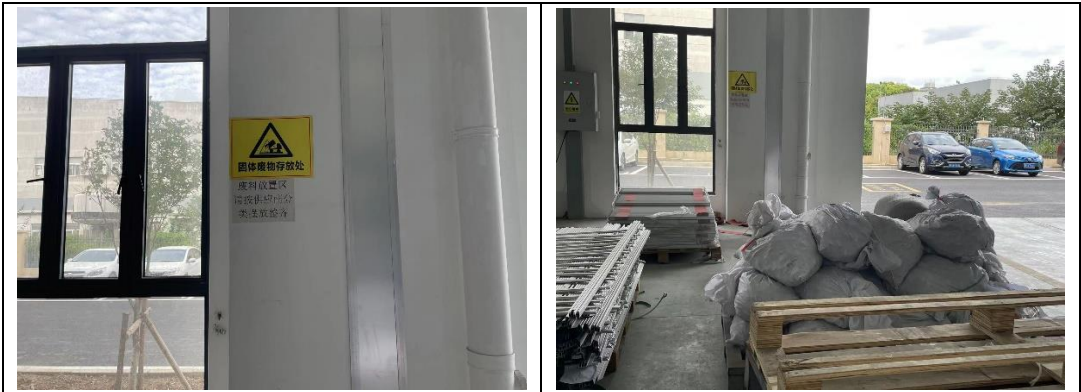
图 3-5 一般工业固废堆场现状图
