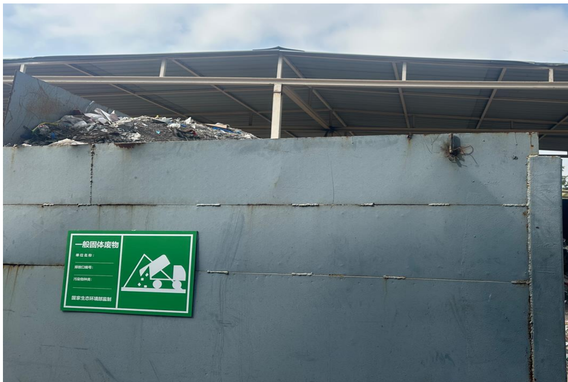
图 4-4 一般工业固废暂存区 (200m 2 )
