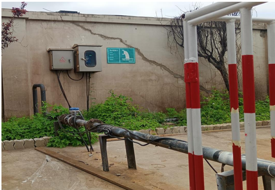
图 4-1 污水排放口现场照片
