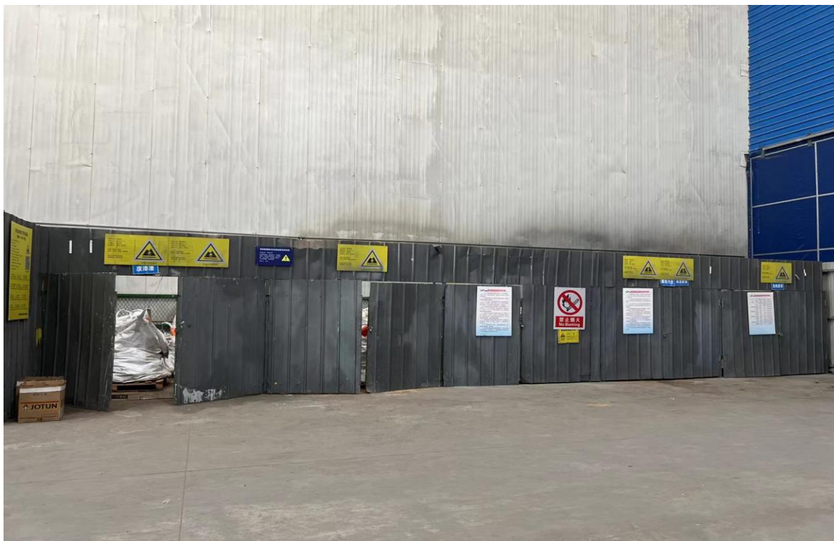
图 4-5 危废暂存区 (100m 2 )
